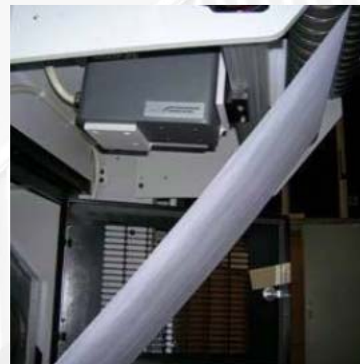
センサーヘッド設置(フレキソプリントユニット)
