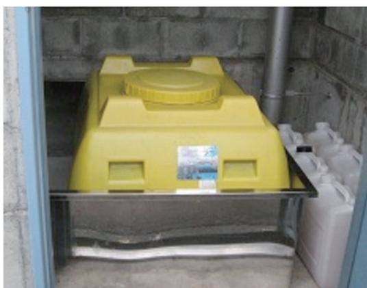
写真 12 漏えい防止措置を施した廃液タンク
