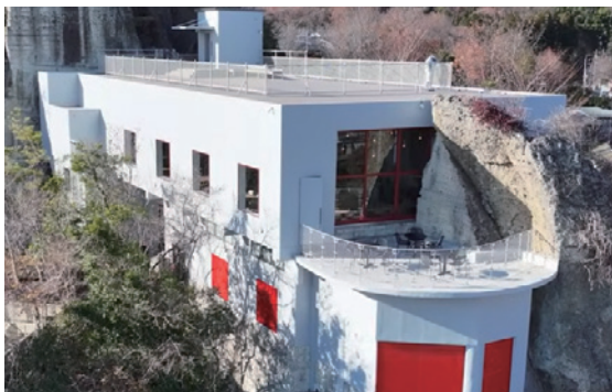
大谷グランド・センター外観
